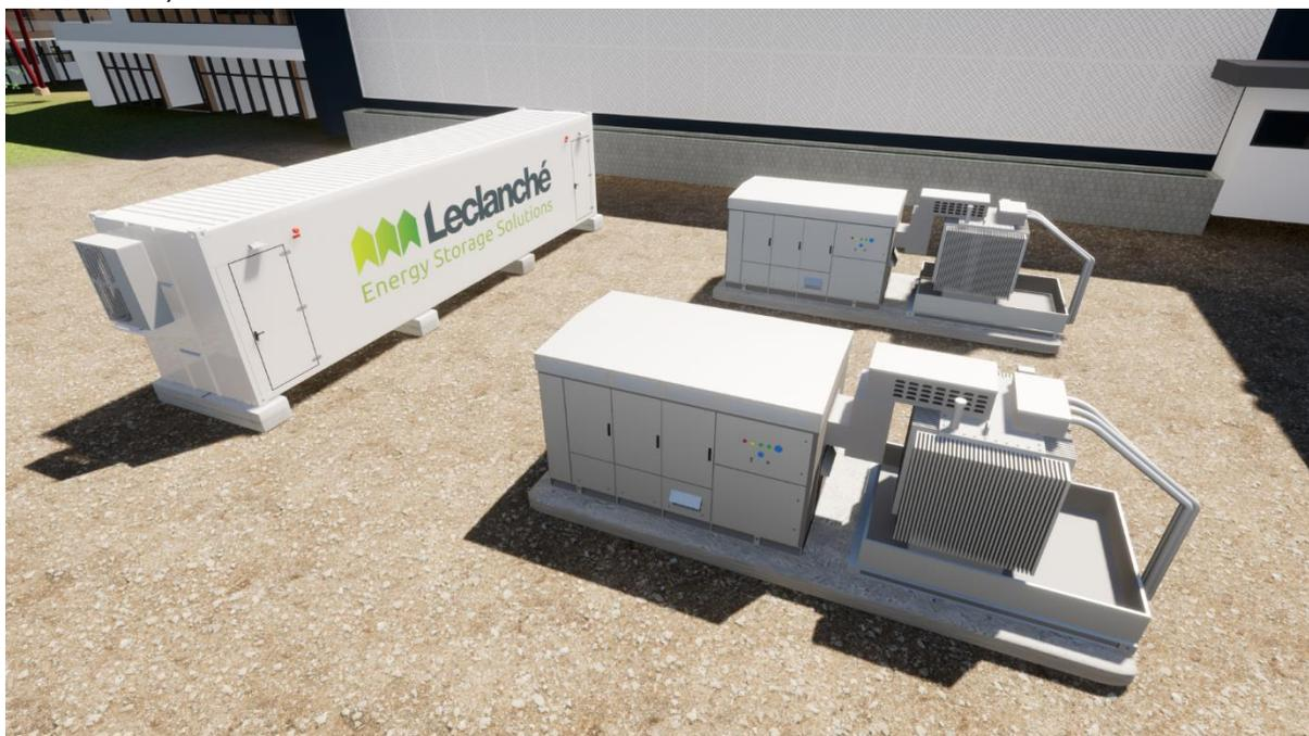
Rendu 3D des composants clés de l'installation de la centrale électrique de Veolia Gas, avec (à gauche) le système de stockage d'énergie par batterie et (à droite) deux onduleurs.
